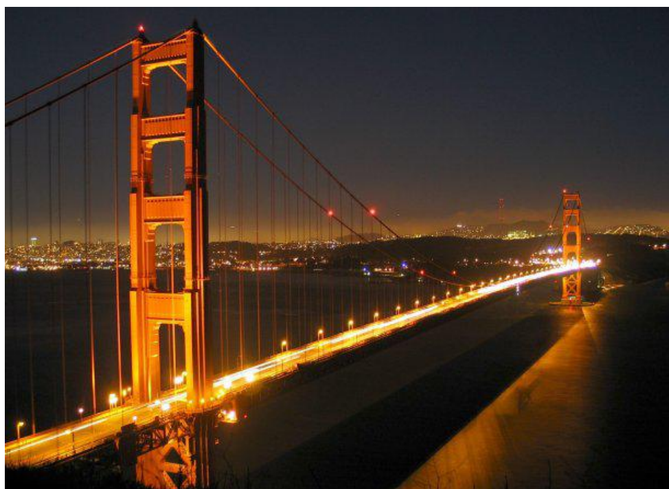
p/ Lòng đường của cây cầu Golden Gate được giữ lên bằng sức căng của những sợi dây cáp thẳng đứng
